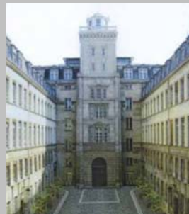
Rue Grenelle 103 (París) 22.000 m2 – Inversión 125 M€ Rehabilitación Oficinas
