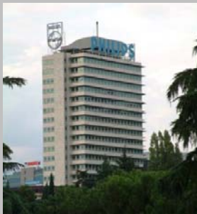
Edificio Philips (Madrid) 33.650 m2 – Inversión 105 M€ 100 % Alquilado a Philips Ibérica. Rehabilitación prevista en 2007
