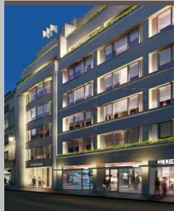
St. Honoré 247-251 (París) 22.000 m2 – Inversión 95 M€ Rehabilitación (Hotel / Oficinas)
